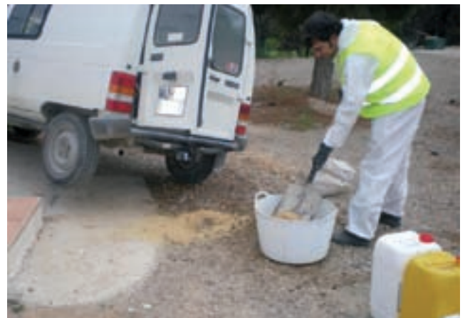
Operario retirando el producto inerte - absorbente a un envase controlado.
