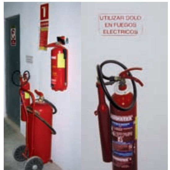
Equipo de extinción de incendios, extintor de CO 2 para fuegos eléctricos.
