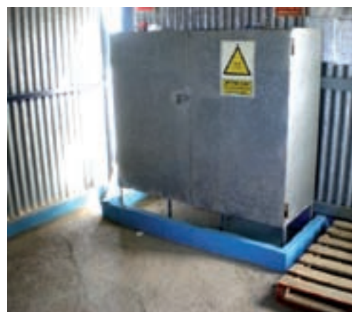
Armario metálico para el almacenamiento de fitosanitarios, con cubeto y suelo de hormigón.
