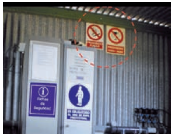
Armarios para guardar las fichas de seguridad de los fitosanitarios y los EPI, junto con la señalización de la prohibición de fumar, comer y beber.
