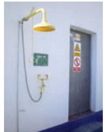
Ducha lavaojos en el acceso al almacén de fitosanitarios.
