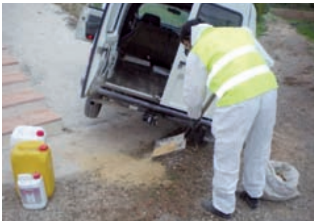
Operario con equipo adecuado para retirar productos tóxicos y advertir su presencia en la vía pública, retira la mercancía del vehículo, controla los envases accidentados y aplica un sustrato inerte para neutralizar el derrame.
