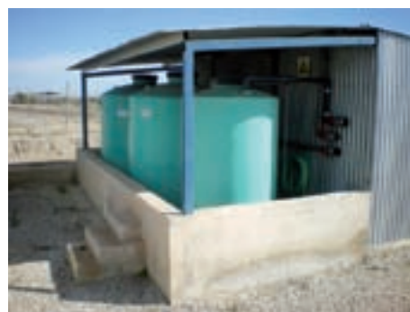
Tanques fertilizantes en el interior del cubeto de retención.
