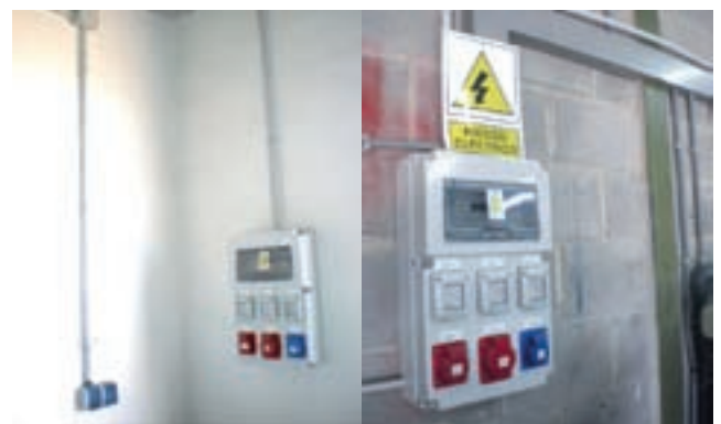
Instalaciones eléctricas en casetas agrícolas conforme al reglamento REBT.
