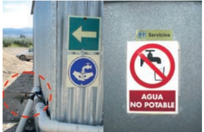
Señalización de agua apta para lavado de manos, indicar en caso de no ser agua potable.
