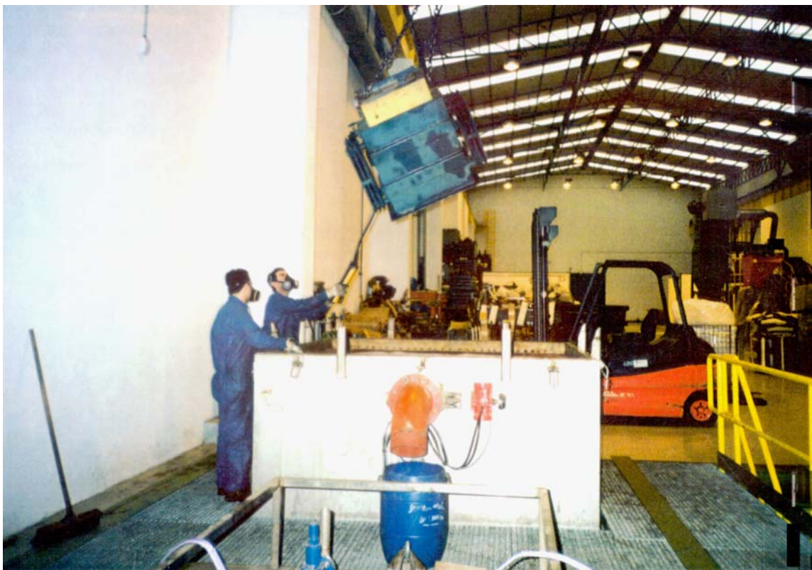
Trabajadores con vestimenta de protección mientras trabajan con un transformador de PCB.
