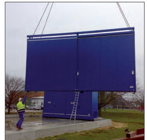
Descarga con autogrúa y colocación sobre solera previamente dispuesta por el cliente
