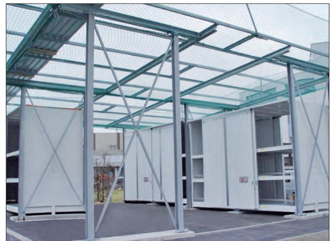
Montaje de un almacén para materias primas consistente en varios almacenes System-Container de DENIOS y una estructura de acero
