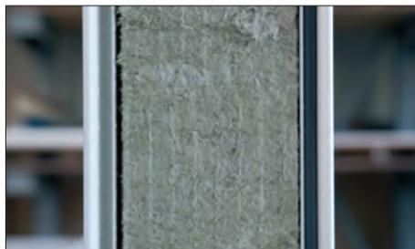
Lana mineral utilizada como aislante de paredes (Clase de material A)
