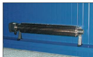
Ejemplo de montaje de la calefacción de tubo aleteado
