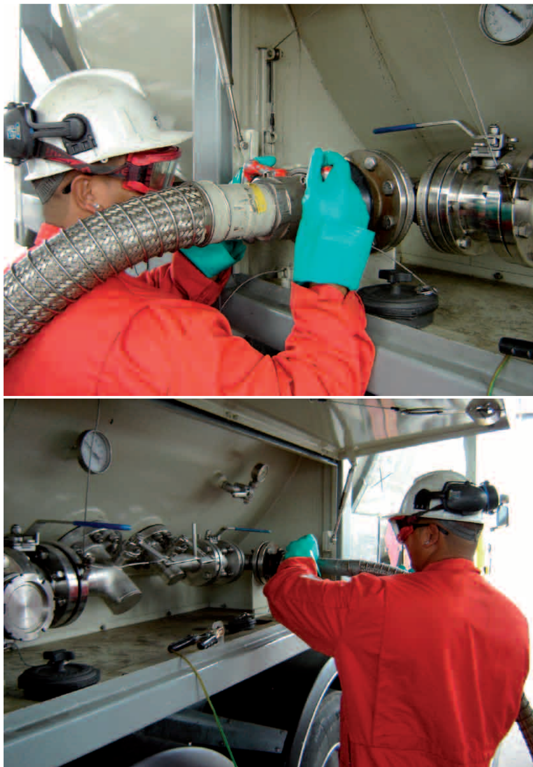
Fig. 4/5 Trabajador con prendas de protección, conectando la conexión de corte seco de fase líquida
