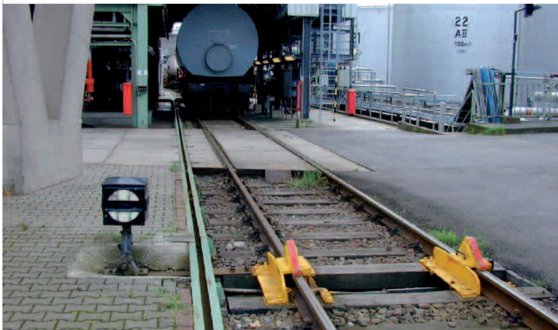
Fig. 6 Descarrilador en una estación de llenado para evitar que otros vagones entren en la estación de carga
