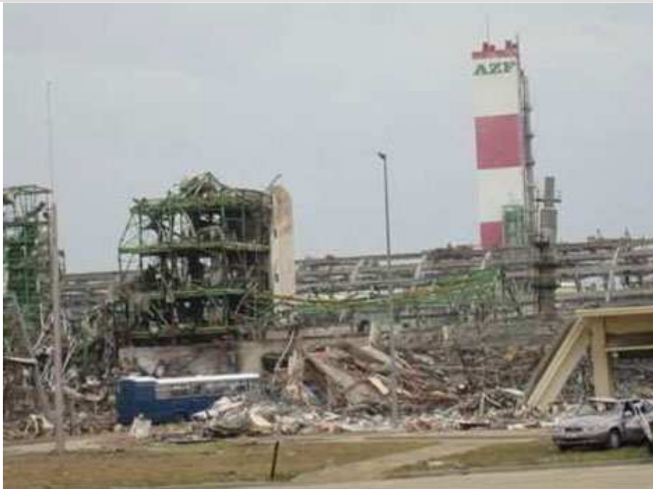
La planta química de AZF en Toulouse quedó totalmente destruida.
